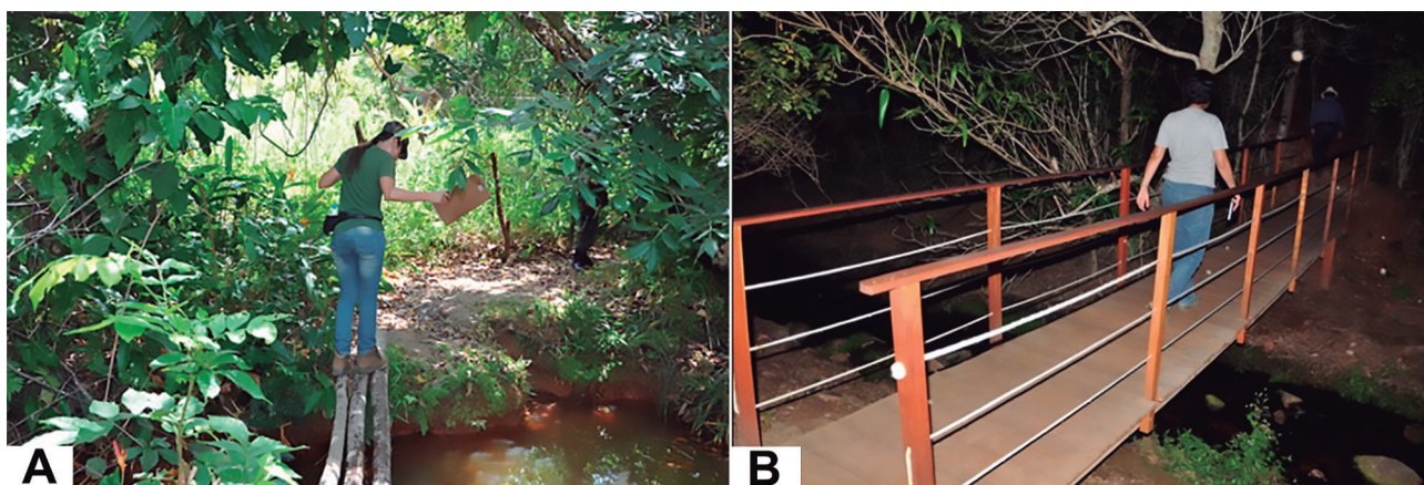
Figura 4 A. Falta de estrutura e segurança para atravessar riachos (Parque Metropolitano Armando de Holanda Cavalcanti – Pernambuco/BR; B. Modelo de passarela feita sobre riacho. A estrutura oferece segurança na passagem dos visitantes, incluindo apoio para as mãos – Parque Ecológico Pedra do Sino – Alagoas/BR.
