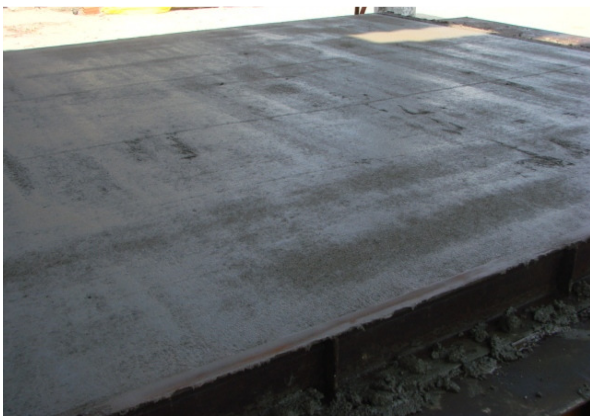
Painel em processo de secagem
