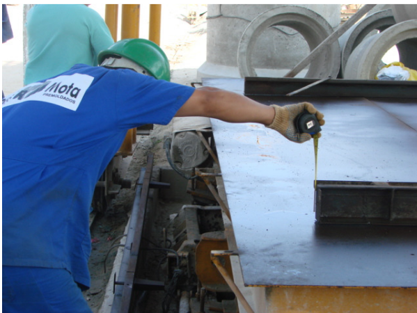
Molde e mesa para fabricação dos painéis
