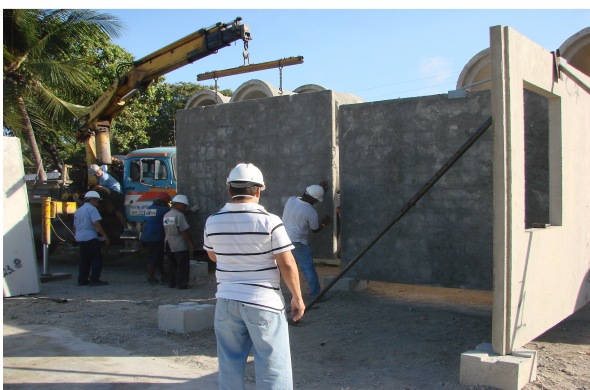
Montagem dos painéis
