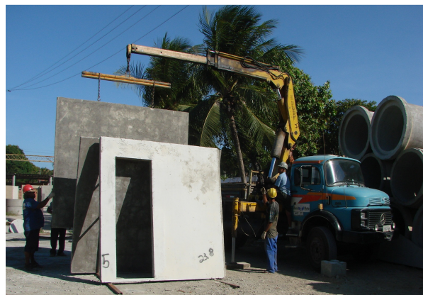
Painel curado, pronto para montagem
