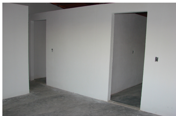
Casa em processo de montagem
