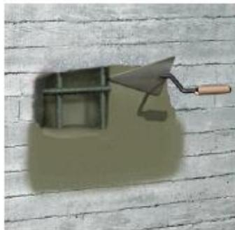
Realizar a recomposição do concreto deteriorado com argamassas de reparo tixotrópicas, tipo **Sika Repair®-222 BR** ou **Sika MonoTop®-622 BR** por aplicação manual, de maneira a preencher todos os vazios entre as barras da armadura ou...
