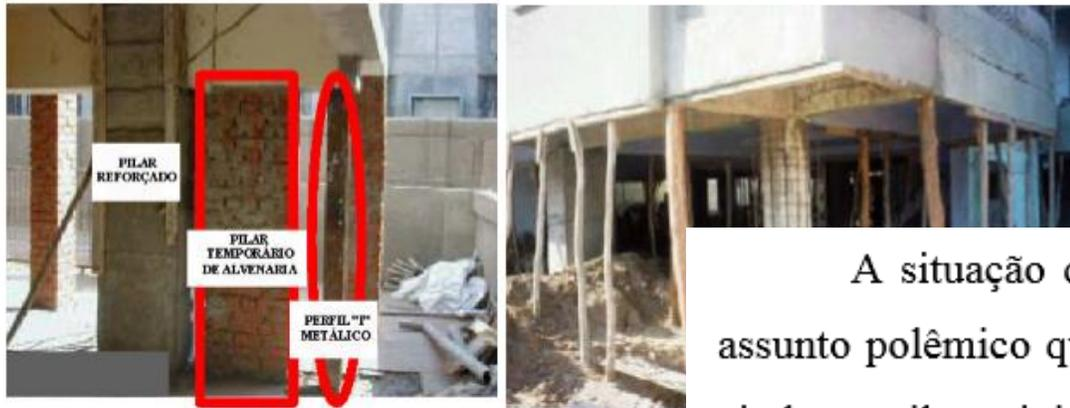
Figura 2.1: Tipos de sistemas de alívio de carregamento
